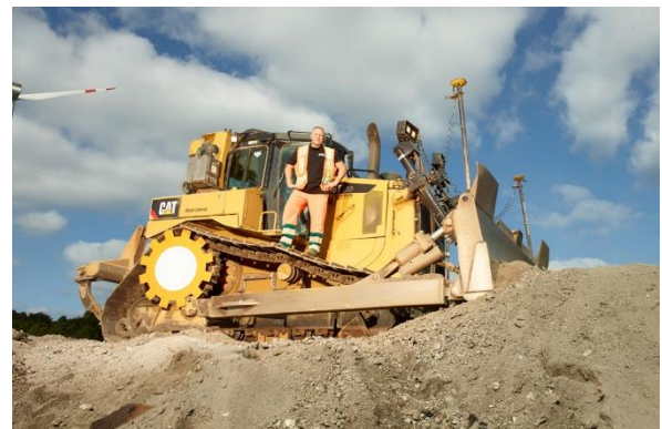
Abbildung: Kettenraupe auf der Deponie
