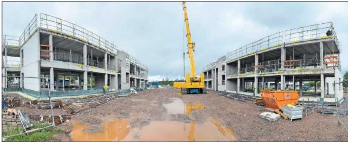
Vor rund vier Wochen waren die Rohbauten beim Monte Mare zwei Stockwerke hoch, inzwischen sind die Gebäude für den Zoll deutlich gewachsen. FOTO:VIEW
