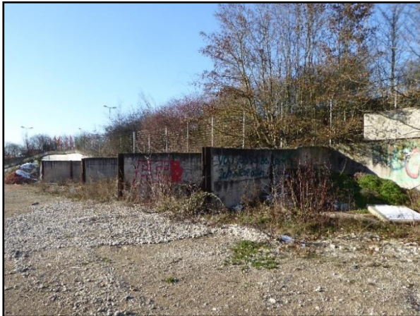
Abb. 8: versiegelte Lagerflächen mit Trennwänden und Böschungsmauer (Blickrichtung Westen, eigenes Foto)
