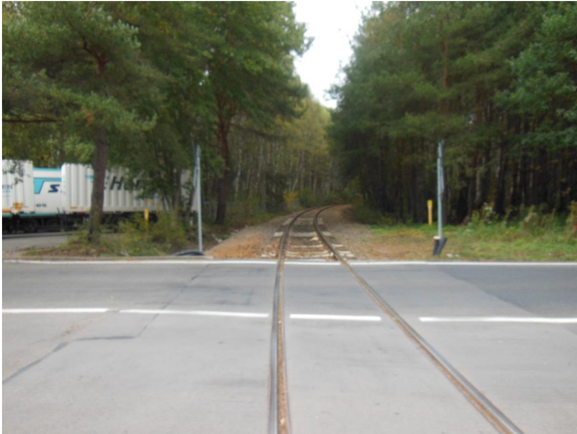
Bild 4: Blick nach Norden. Auf der rechten (östlichen) Seite des Gleiskörpers wird eine Steuerleitung für eine elektrisch ortsgestellte Weiche (EOW in ca. 200 m Entfernung) erforderlich. Die Weichenanlage ist bereits vorhanden. (Bildquelle: WSW & Partner, Oktober 2017)
