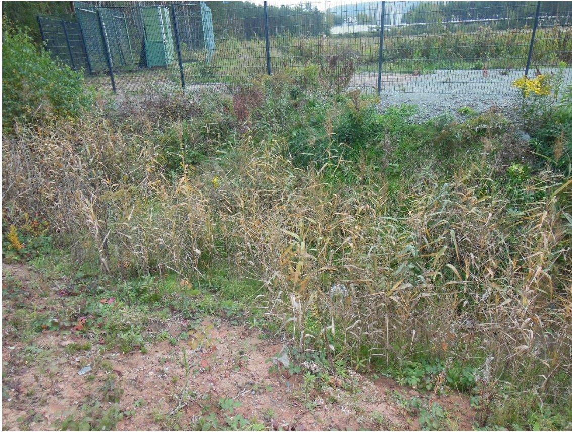
Bild 3: Auf der Südseite der westlich des Bahnübergangs anschließenden „Von Millerstraße“ verläuft ein Entwässerungsgraben (zum Zeitpunkt der Bestandsaufnahme trocken) (Bildquelle: WSW & Partner, Oktober 2017)
