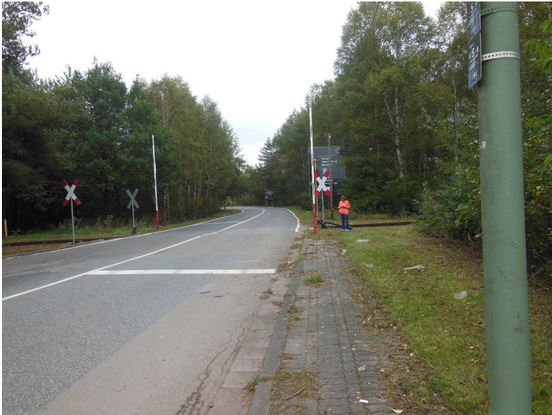
Bild 1: Blick auf den Bahnübergang in der „Von Miller Straße“ aus westlicher Richtung (Bildquelle: WSW & Partner, Oktober 2017) Die vorhandene Fahrbahn wird auf 7,00m verringert und der auf der rechten (südlichen) Seite befindliche Gehweg um ca. 1,5m als kombinierter Geh- und Radweg verbreitert.
