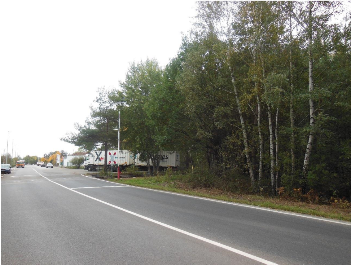
Bild 5: Blick aus östlicher Richtung auf das geplante Bauvorhaben: Auf der rechten (nördlichen) Fahrbahnseite ist die Errichtung eines Schalthauses (ca. 5 m 2 ) mit vorgelagerter befestigter KFZ – Abstellfläche (ca. 35 m 2 ) vorgesehen. (Bildquelle: WSW & Partner, Oktober 2017)
