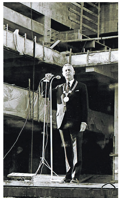
Der ehemalige OB Sommer beim Richtfest am 16. September 1965 FOTO: LEPLLA / STADTARCHIV
