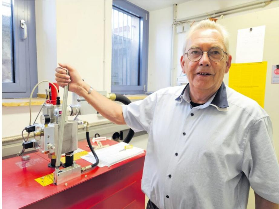
Im Notfall lassen sich Hydraulikaufzüge per Handpumpe bewegen, wie hier von Matthias Stummann im Keller im Rathaus Nord demonstriert. Eine Pumpbewegung entspricht einem Millimeter. FOTO: PS
