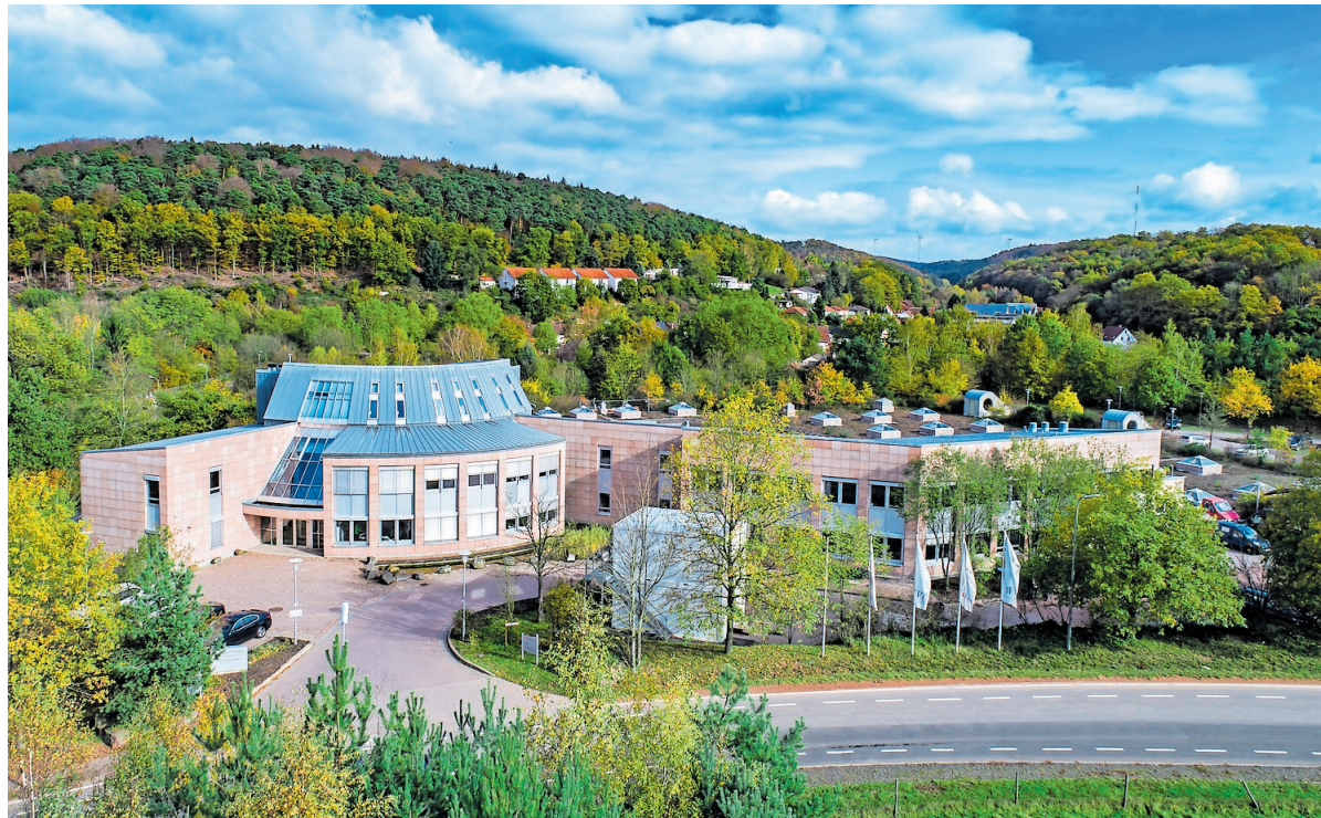
Die Zentrale der Stadtentwässerung am Blechhammerweg. Hier werden die digitalen Anträge bearbeitet.
